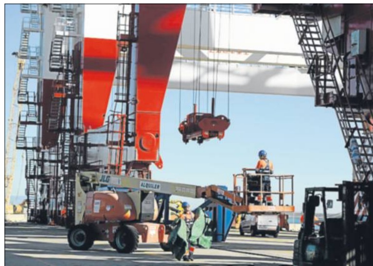
Tres nuevas grúas pórtico para la Barcelona Europe South Terminal de HPH ALEX GARCÍA
